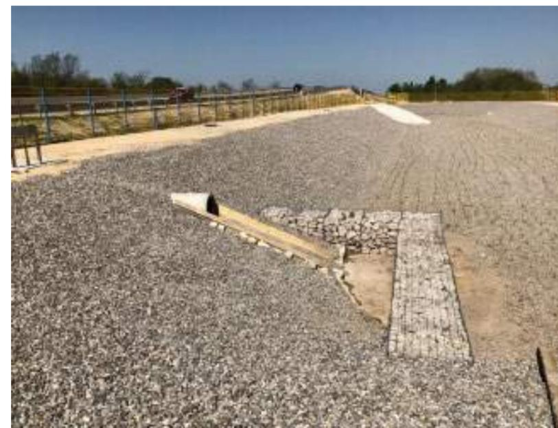
Figure 6 : Aspect d'un bassin envisagé (source : Setec)
